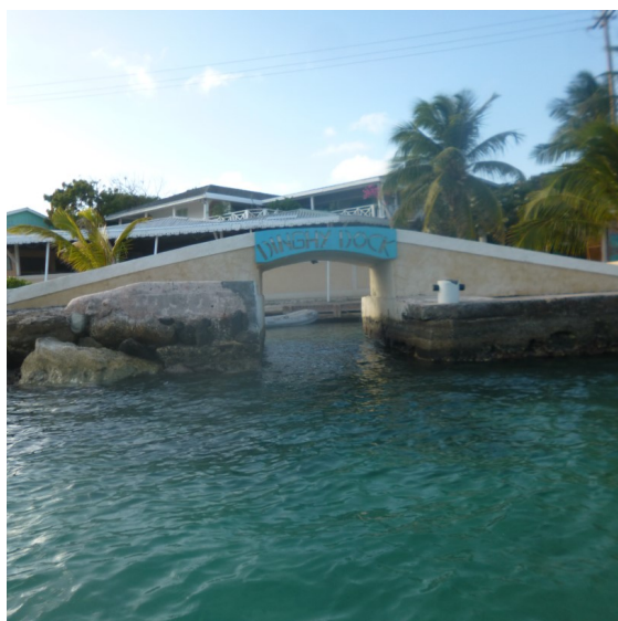
Passage pour ranger son annexe à Clifton Village
